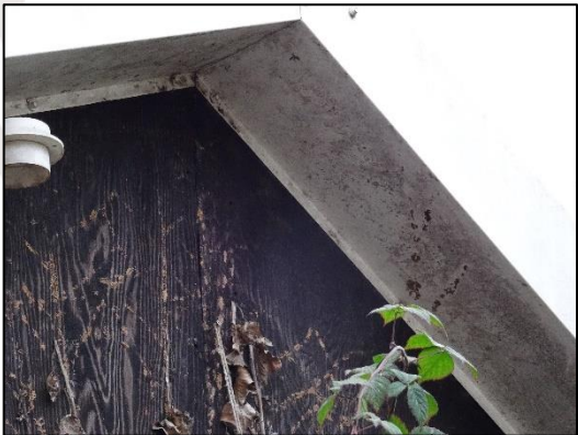
Fig. 2.8 Dakrand gebouw nr. 2 (bron: FF Solutions)
