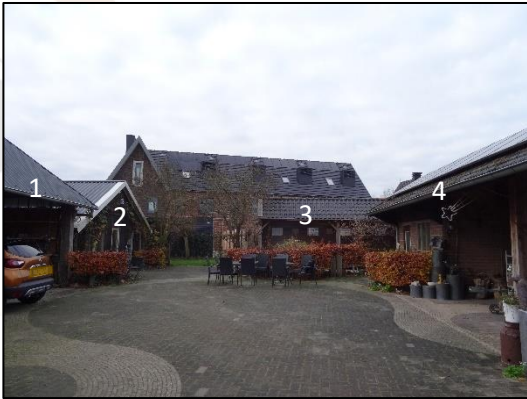
Fig. 2.4 Aanwezige bijgebouwen, met nummering (bron: FF Solutions)
