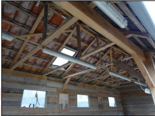
Fig. 2.10 Binnenzijde dak gebouw nr. 3 (bron: FF Solutions)
