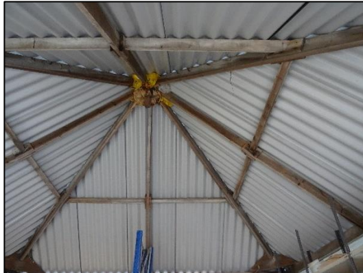
Fig. 2.7 Binnenzijde dak gebouw nr. 1 (bron: FF Solutions)
