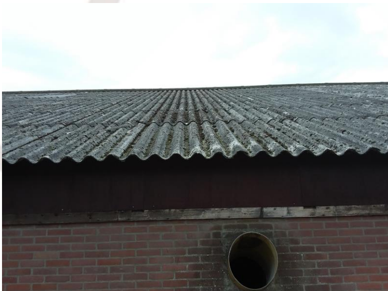
Dak zonder invliegopeningen, muren met invliegopeningen vogels
