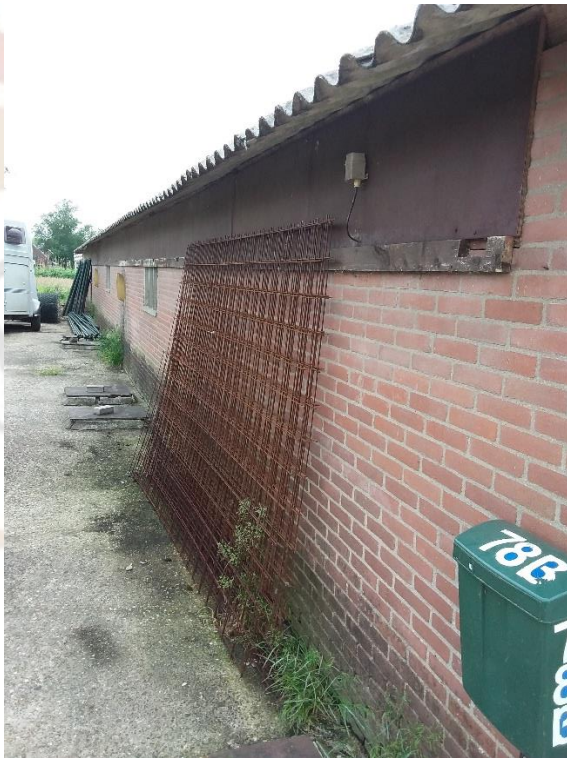
Noordelijke buitenzijde varkensstalling
