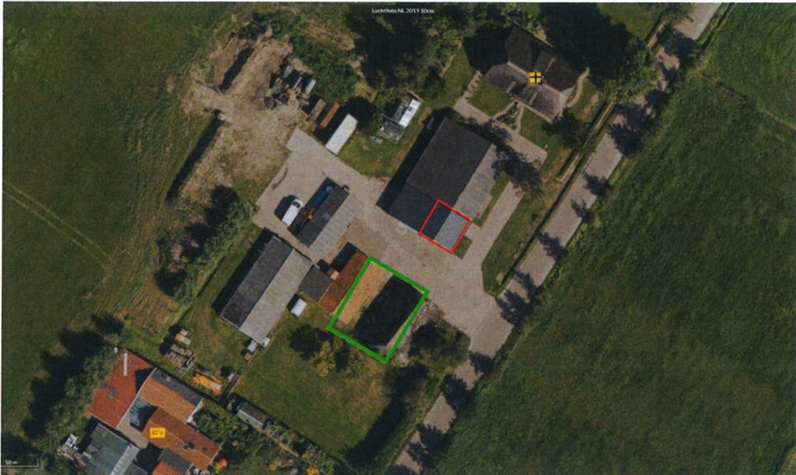
Figuur 4: luchtfoto met projectgebied (indicatief): groen is locatie nieuw te bouwen woning, rood is tijdelijk woonverblijf.
