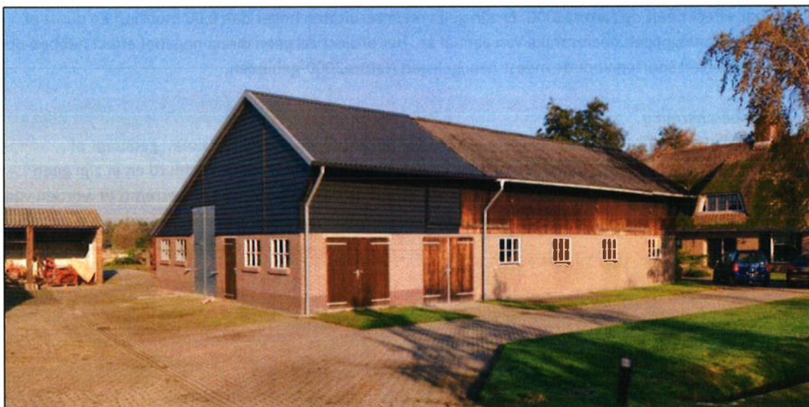
Figuur 11: de voormalig agrarische schuur waarbinnen de tijdelijke woning gerealiseerd wordt.
