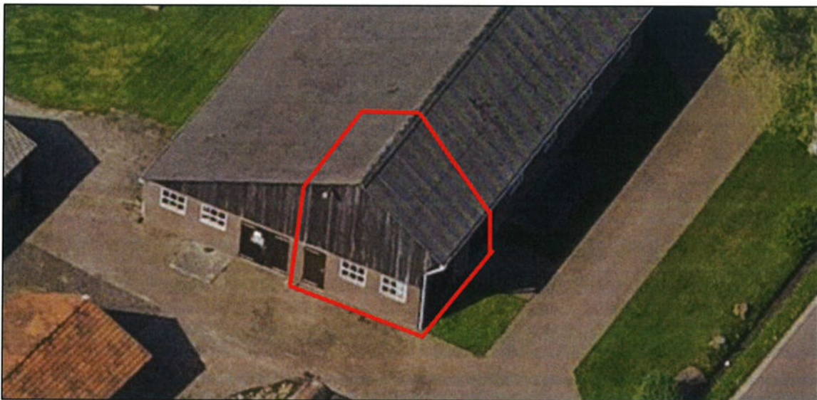
Figuur 7: luchtfoto bestaande situatie april 2018. Inmiddels gedateerd: het dak boven het beoogde woongedeelte (rood omkaderd) is vervangen.
