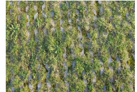
grasklinkers bieden stevigheid aan de in- en uitrit en geven bovendien een groen beeld
