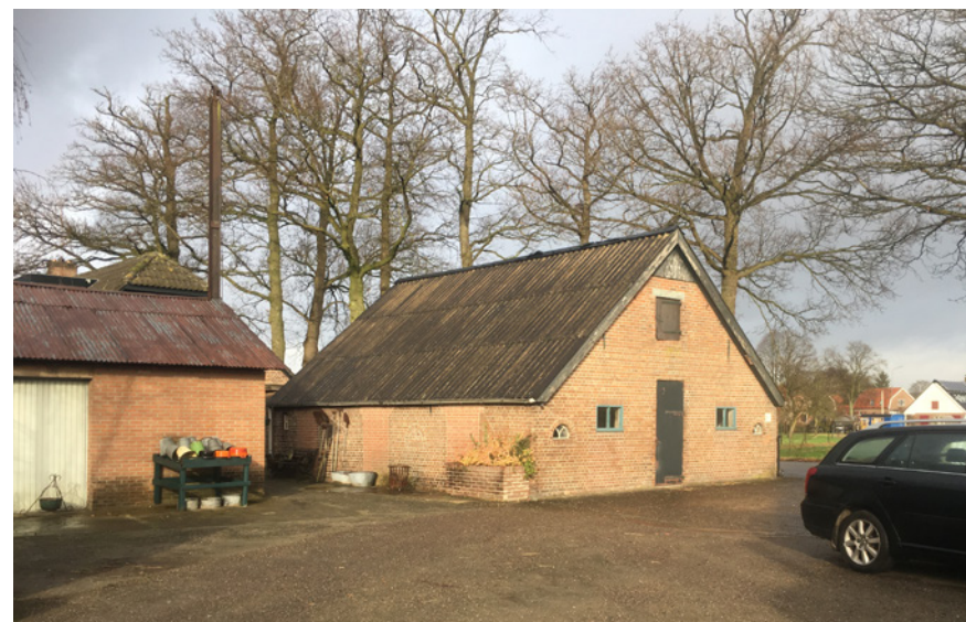
De achterzijde van de te behouden stal uit 1926.
