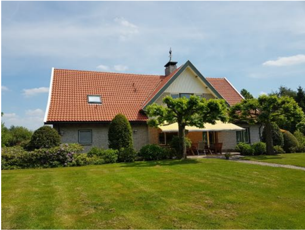
Figuur 1 De planlocatie is onderdeel van de Havenkom te Nijkerk. De villa van [REDACTED] (Nijverheidstraat 6) vormt het noordelijke gedeelte van het plangebied.
