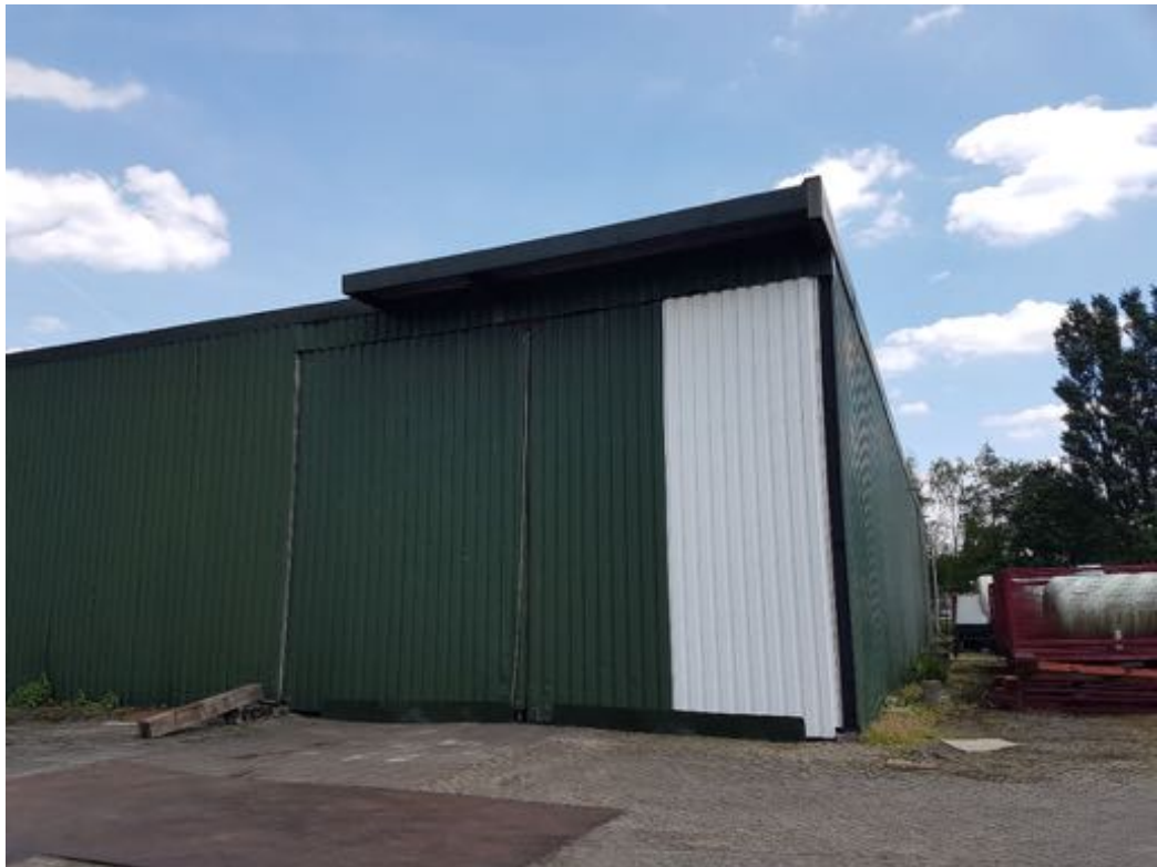
Figuur 7 De loods op het voormalige industrieterrein is vrij toegankelijk voor broedvogels. Voor zowel huismus, gierzwaluw als vleermuis biedt de loods geen potentiële verblijfplaats.
