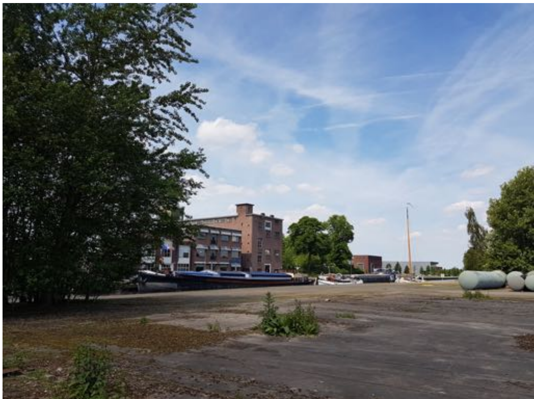
Figuur 8 Het voormalige industrieterrein is grotendeels verhard. Tussen de verharding groeien kruidachtige planten. Het industrieterrein is direct gelegen aan de Arkervaart.
