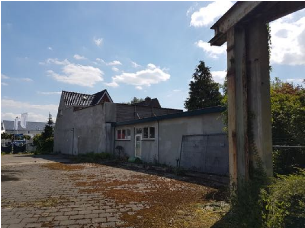
Figuur 10 De woningen ter hoogte van Ardeschstraat 4 en 6 liggen naast het voormalige industrieterrein. Beide woningen hebben potentie voor huismus en vleermuis.
