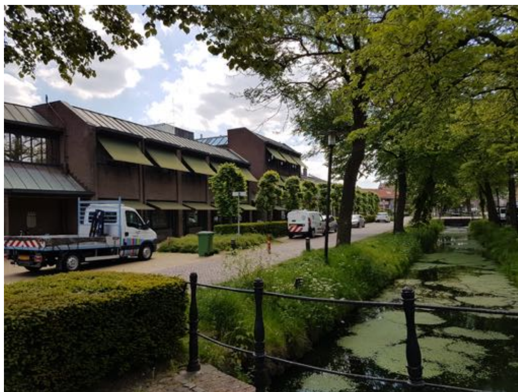
Figuur 14 In de gedeelten van het gemeentehuis die gesaneerd worden zijn geen geschikte rust en verblijfplaatsen voor huismussen, gierzwaluwen en vleermuizen aangetroffen.
