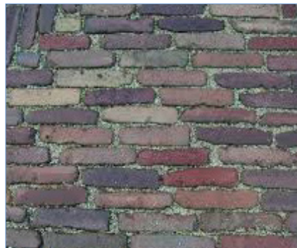
Gebakken klinkers als erfverharding.
