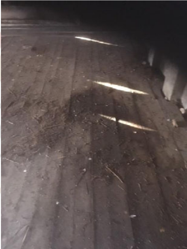
De zolder bevat geen sporen van beschermde soorten (Bron: FF Solutions)
