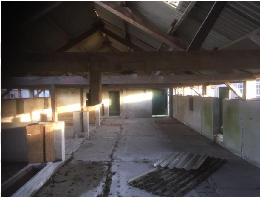
De vloeren van de schuren zijn uitgevoerd met beton (Bron: FF Solutions)
