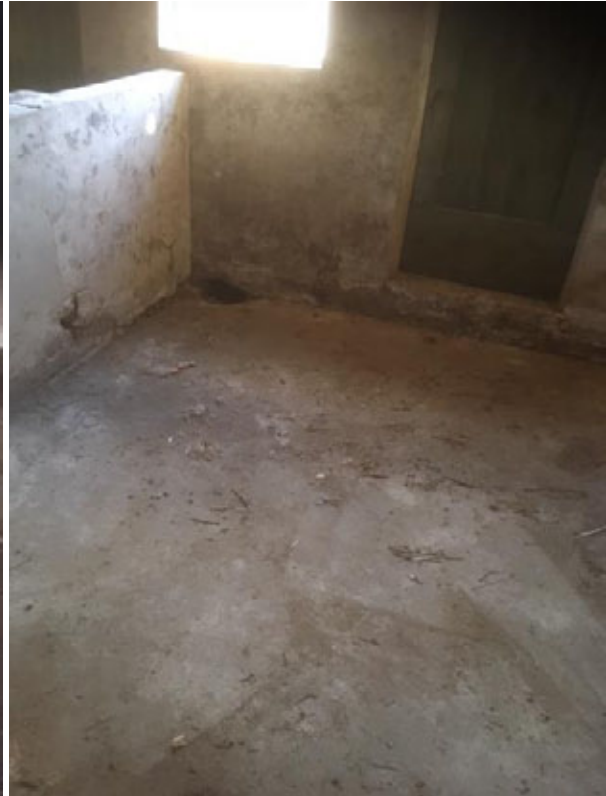
De spouwmuren bevatten openingen (Bron: FF Solutions)
