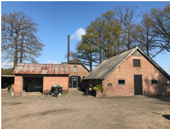
Figuur 4: Woonboerderij op achtergrond (A), te handhave schuur aan de rechterzijde (B) en garage/hooischuur aan linkerkant (C).
