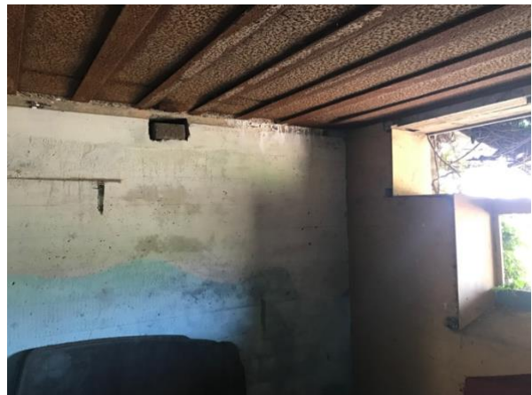
Figuur 11: Binnenzijde Bunker (H).
