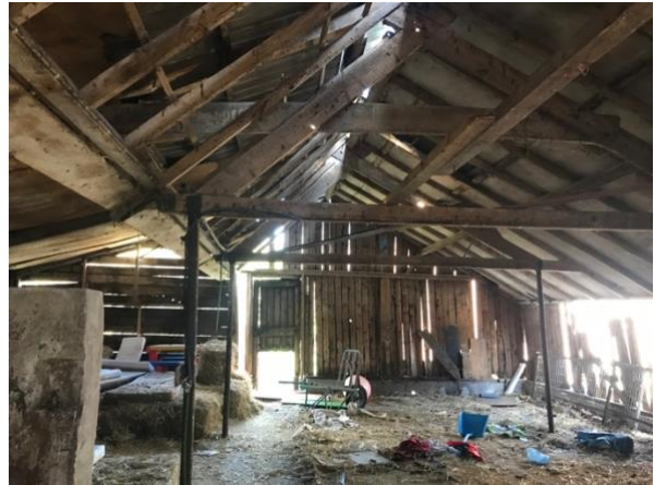
Figuur 7: Binnenzijde houten schuur (E).
