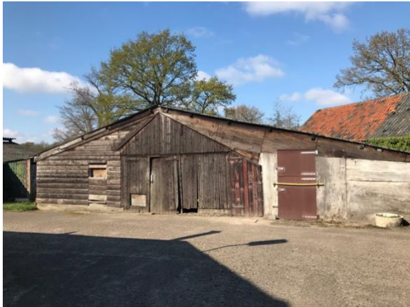
Figuur 6: Buitenzijde houten schuur (E).
