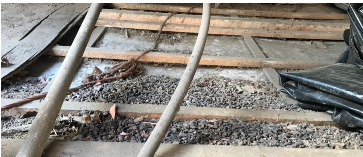
Figuur 20: Uitwerpselen van ratten op het dakbeschot van de houten schuur.
