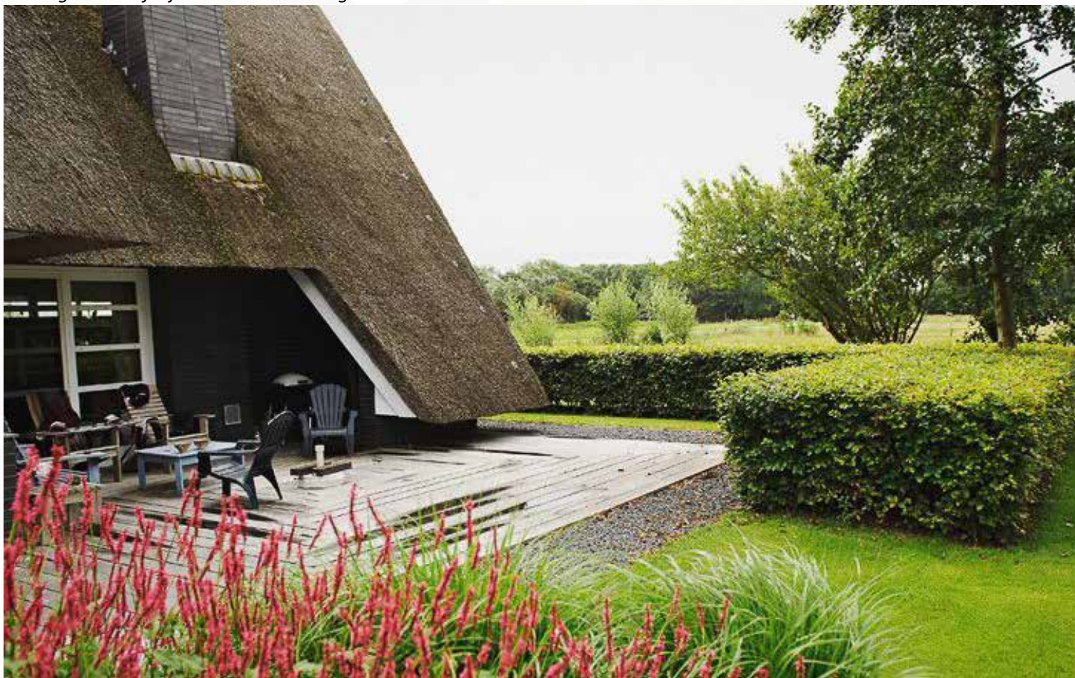
Woningen met afwijkende architectuur grenzend aan de beekzone
