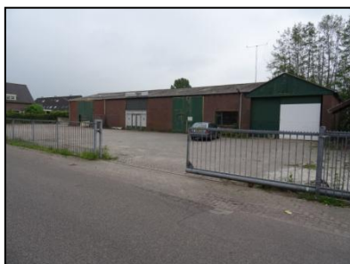
Figuur 4. Noordelijk deel onderzoekslocatie met bedrijfshallen.
