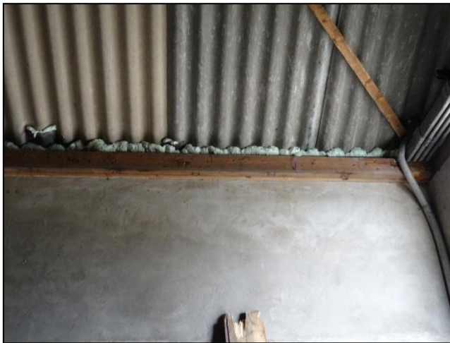
Figuur 10. Bedrijfshal met zadeldak met golfplaten, zonder dakbeschot.
