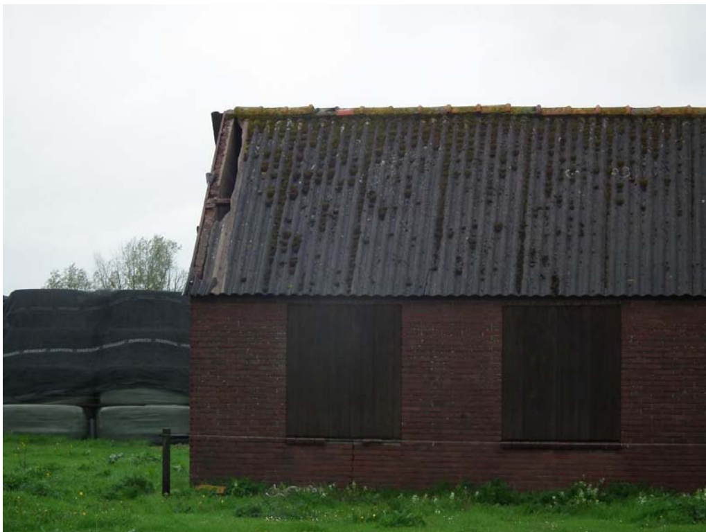
Figuur 4 Ten noorden van de Buntwal 1 is een ouder schuurtje gesitueerd. Het dak is deels kapot waardoor de betreffende schuur potentie biedt voor steenuilen.
