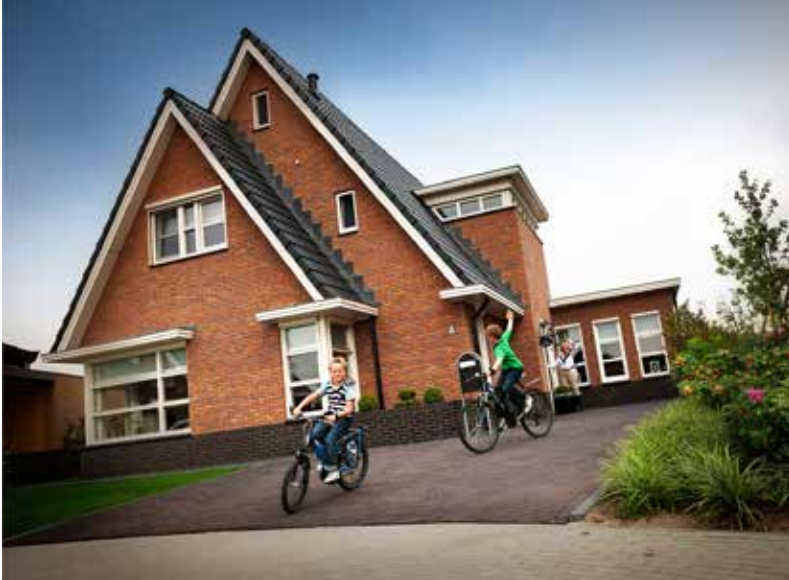
Gevels van metselwerk
