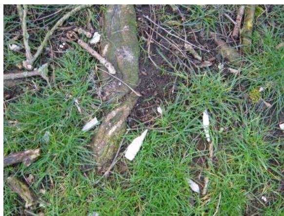
Foto 7: Stukjes asbest door instorten op maaiveld
