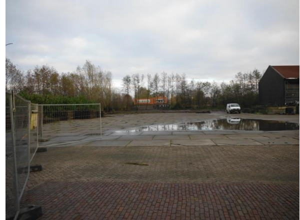
Vanuit zuidwestelijke richting nabij boring 1
