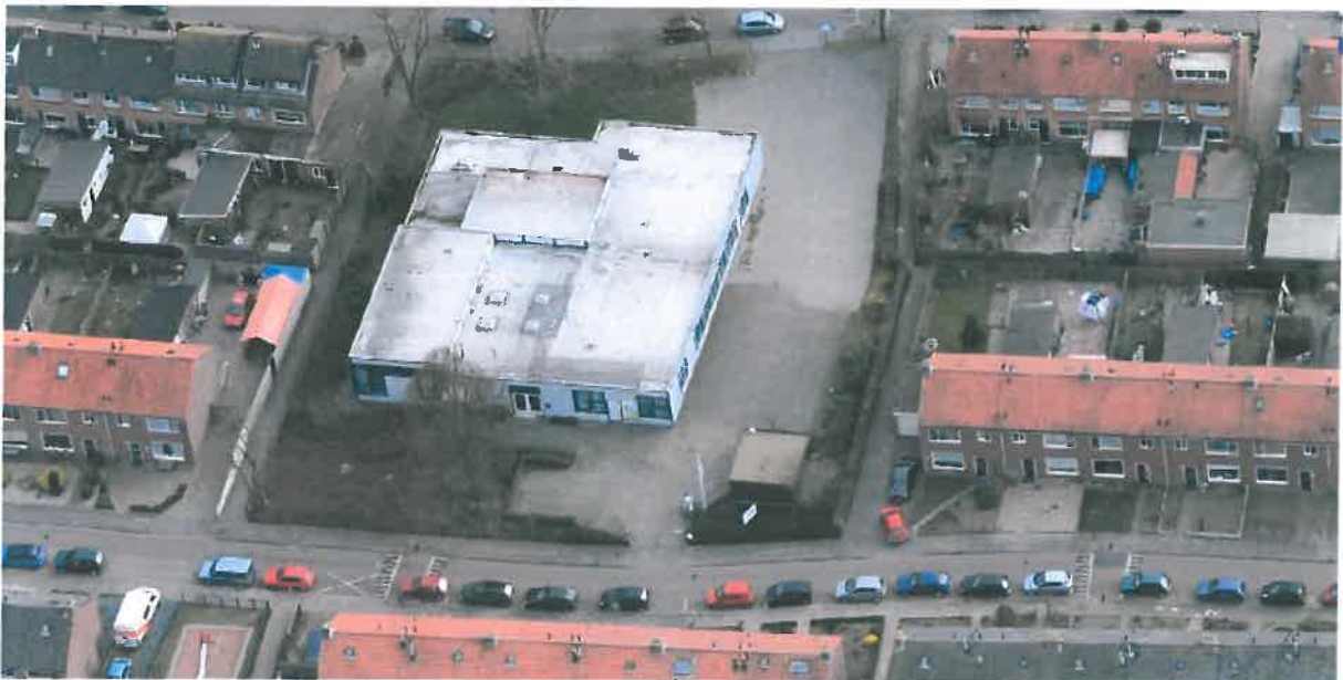
Situatie vogelvlucht (toen de opstallen op het perceel nog niet gesloopt waren)
