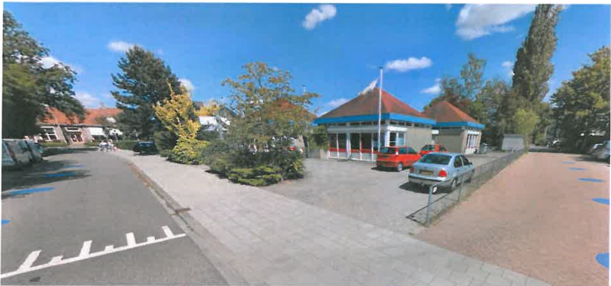
Huidige situatie aanzicht vanaf Meinsstraat
