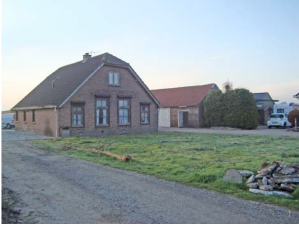
Foto 1. Oorspronkelijke woning (1) en rechts de huidige werkplaats (3).
