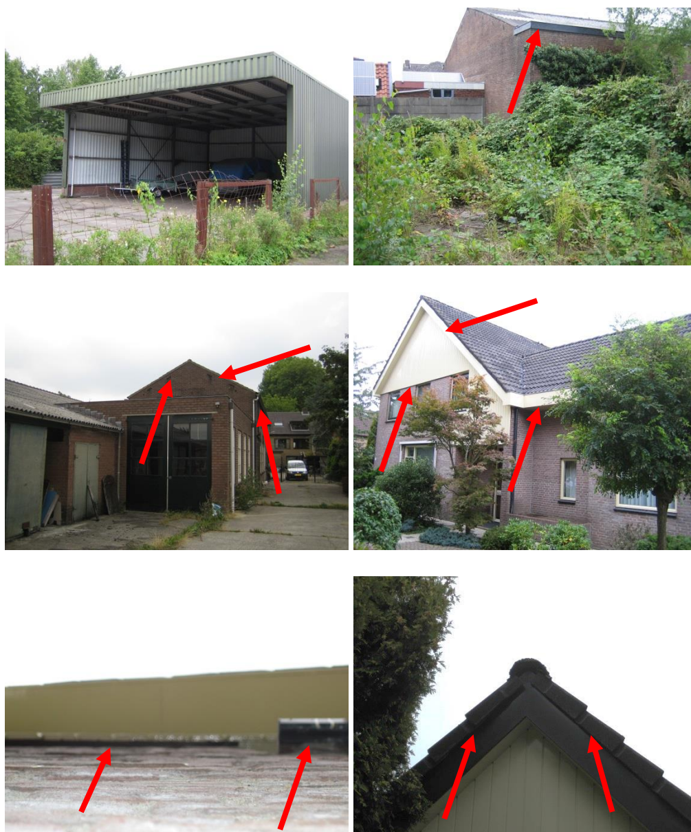
Afbeelding 3: v.l.n.r.: loods in deelgebied 1 (ongeschikt voor vleermuizen); loods in noorden van deelgebied (mogelijk geschikt); schuur (oosten deelgebied) welke mogelijk geschikt is als verblijfplaats; woning aan de Vrijheidslaan met overstekende pannen en kierende gevelbetimmering; close-up kierende gevelbetimmering woonhuis; overstekende dakpannen bijgebouw woning. Rode pijlen geven de locaties aan van mogelijke verblijfplaatsen vleermuizen (SAB, 2013)
