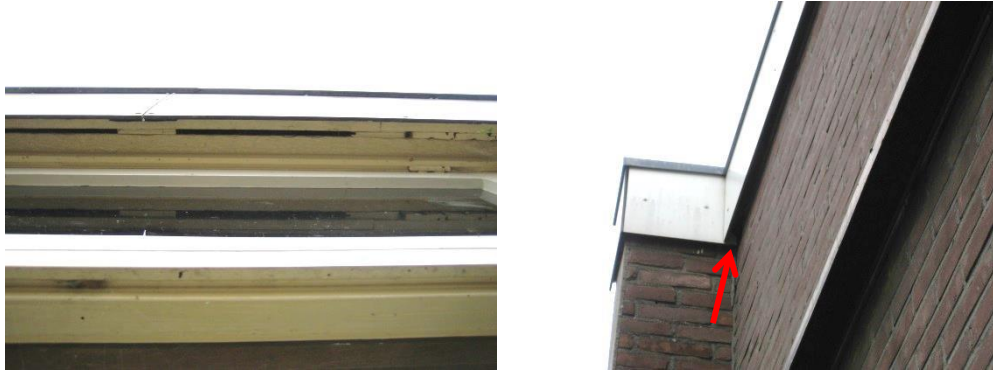
Afbeelding 10: spleten achter de gevelbetimmering van het voormalige kantoor (links) en kierende gevelbetimmering nabij de ingang aan de Venestraat (rechts), SAB (2013).
