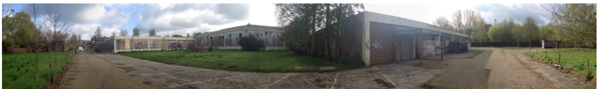
Foto 3: vanuit noordwesthoek locatie rechts noordzijde locatie, links westzijde locatie
