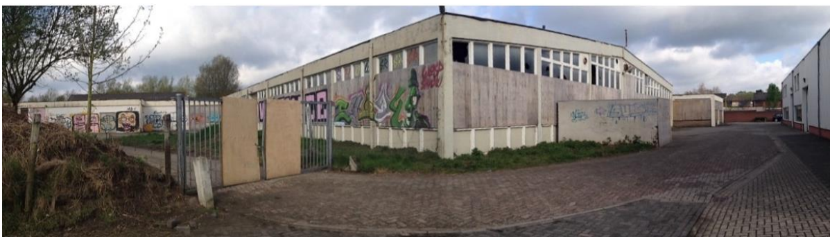
Zicht op projectlocatie en pand voormalige knopenfabriek
