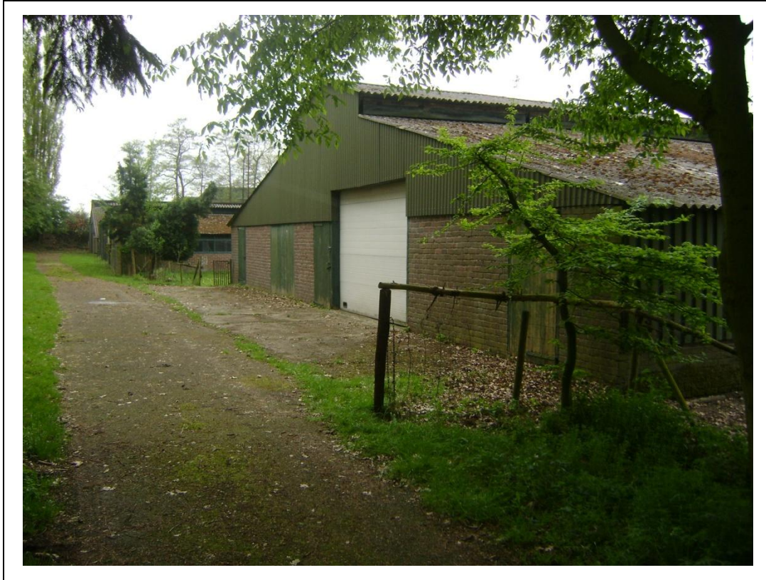
Foto 1. voormalige kippenschuren op zuidelijk deel onderzoekslocatie
