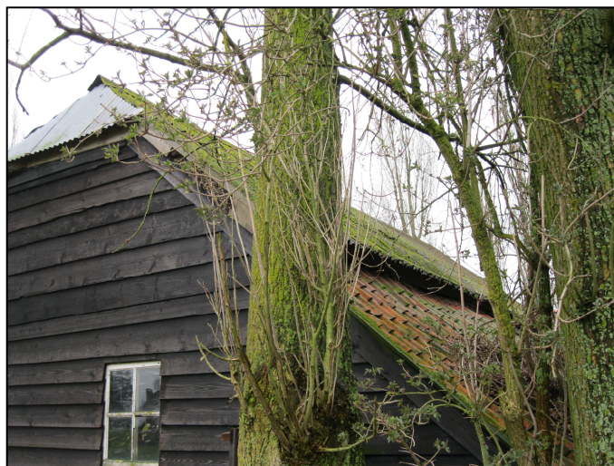
Figuur 1: type betimmering waarachter vleermuizen verblijfplaatsen kunnen vinden.
