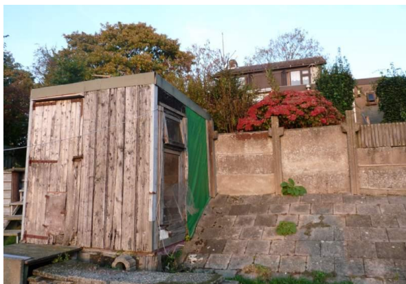
Fig. 7. Houten opslagschuurtje beneden aan de dijk, met de woning op de achtergrond.
