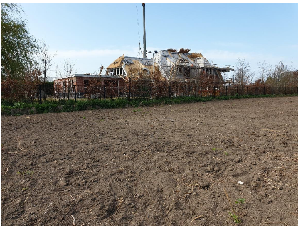
Figuur 4 Bouwwerkzaamheden op het perceel ten zuiden van de planlocatie.
