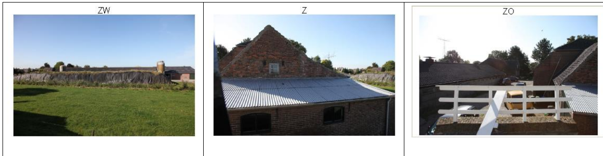
Figuur 9: zicht vanaf de molen richting zuiden (nieuwbouwlocatie woning)
