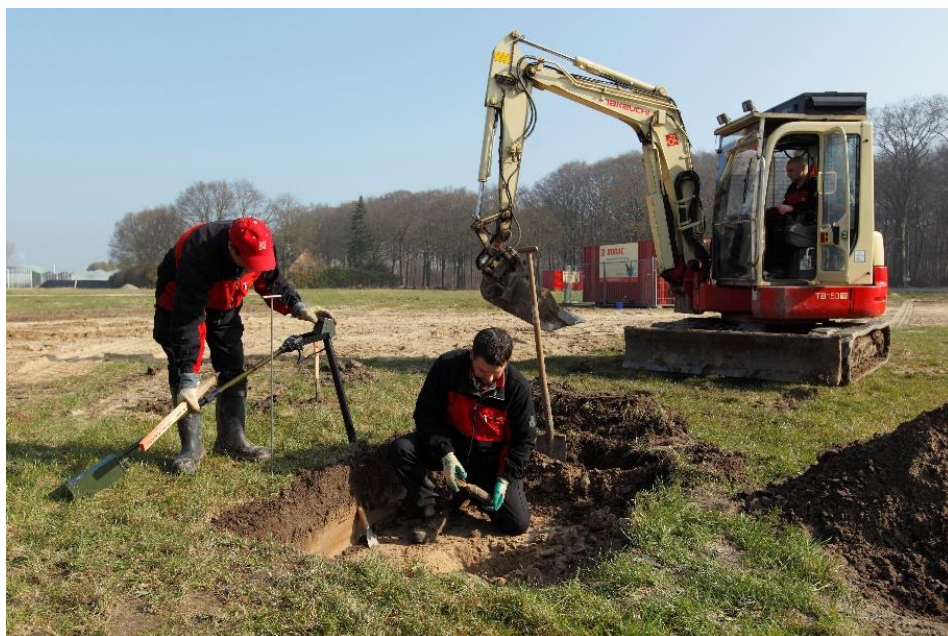
Figuur 6: Benaderen objecten m.b.v. beveiligde graafmachine.
