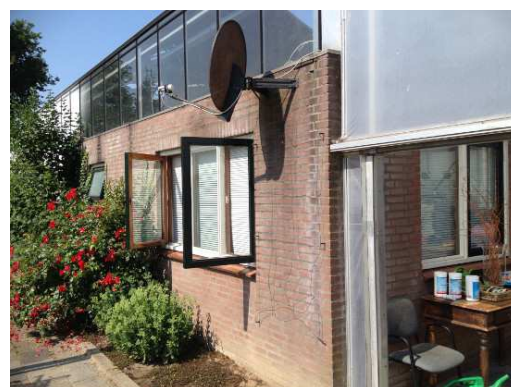
Figuur 4. Kantoorgedeelte van het kassencomplex.
