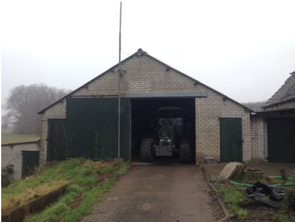
Figuur 3 De schuren bestaan uit steense muren met een golfplaten dak. De schuur naast/tegen de woning is in gebruik als werkplaats.
