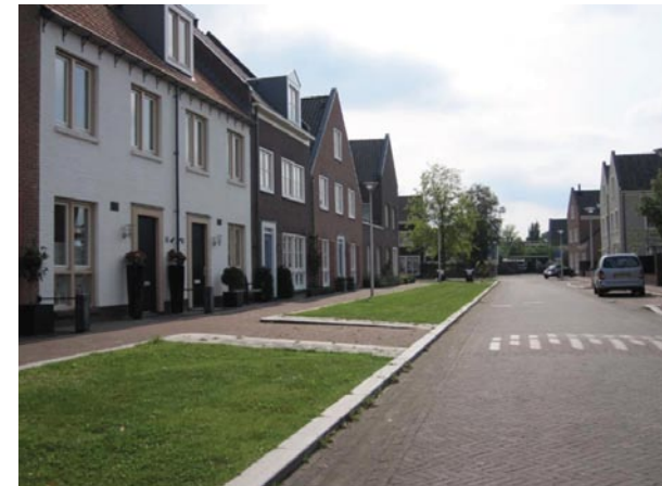
Onderscheid binnen een rij door kleurgebruik, kapvorm en gevelindeling
