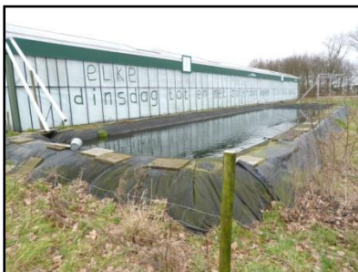
Figuur 6. Waterbassin op onderzoekslocatie.
