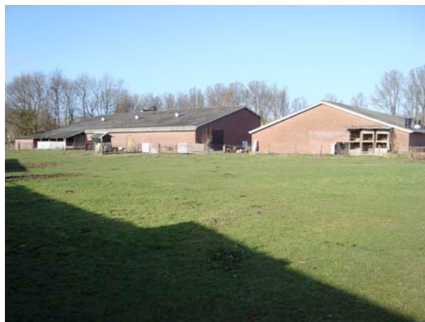
Foto 2. Te slopen gebouwen in noordelijke richting gezien.
