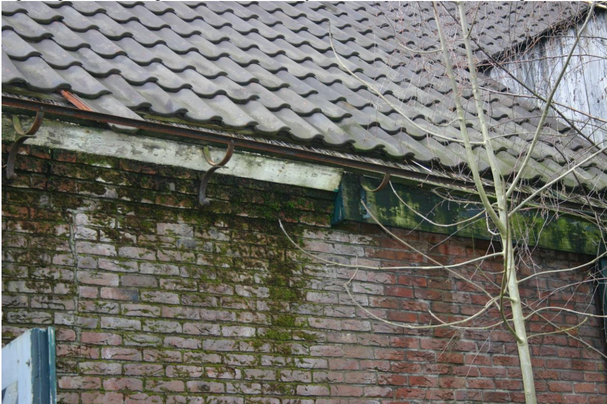
Figuur 7. De onderste rij dakpannen is vrijwel volledig afwezig.
