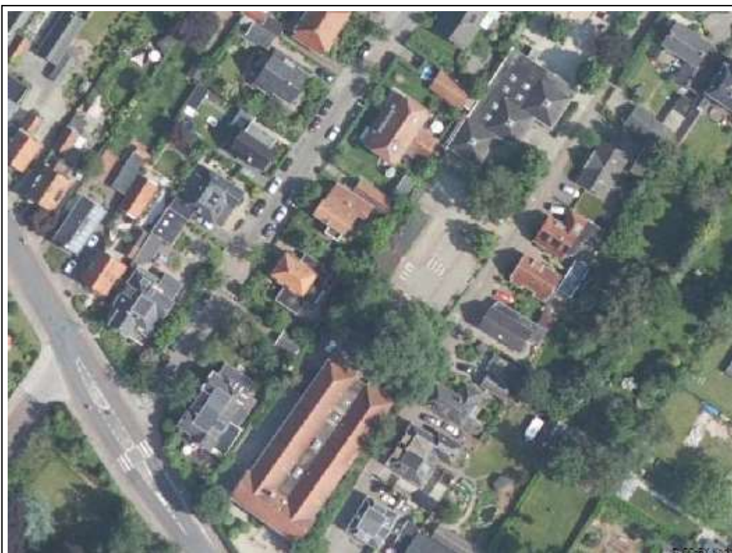
Huidige situatie met aan noord en zuidzijde de (voormalige) schoolgebouwen en midden schoolplein, met monumentale iep.
