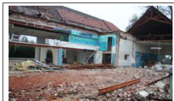
Sloop van de voormalige Propschool in Lochem
