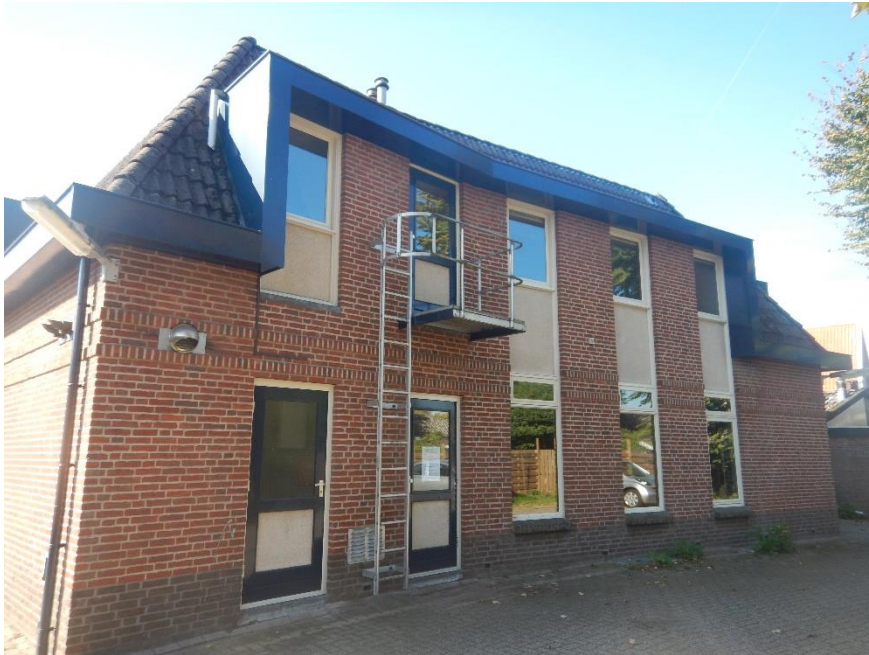
5 Achterkant van het gebouw met goed aangeengesloten gevelplaten.
