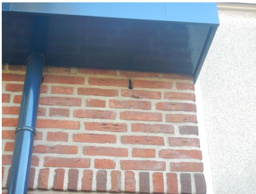
7 Open stootvoeg met daarachter een geïsoleerde spouwmuur.
