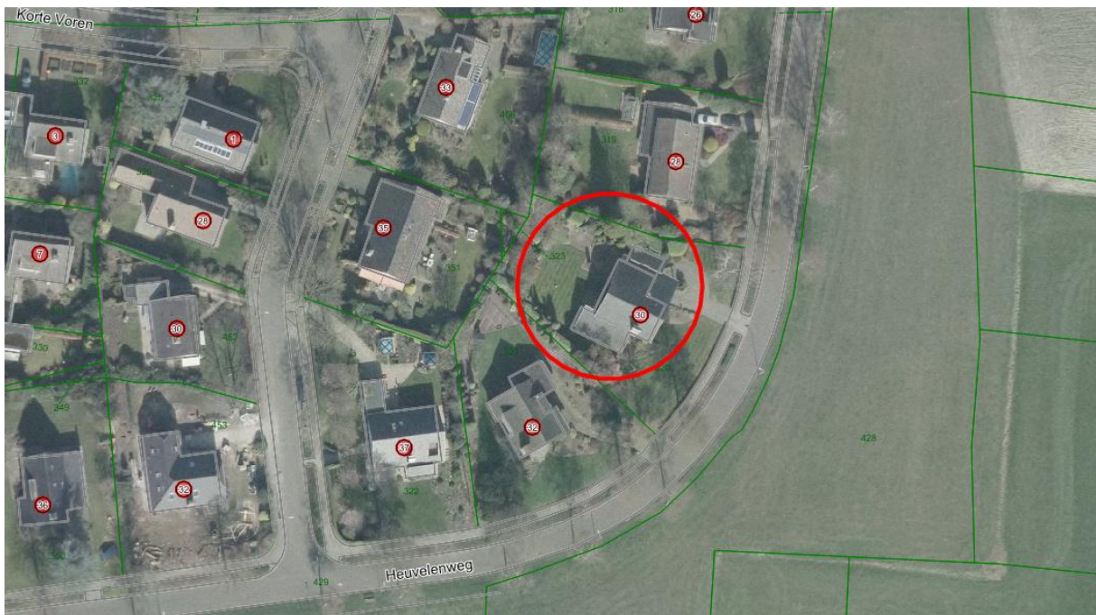
Figuur 1: Luchtfoto perceel Heuvelenweg 30
