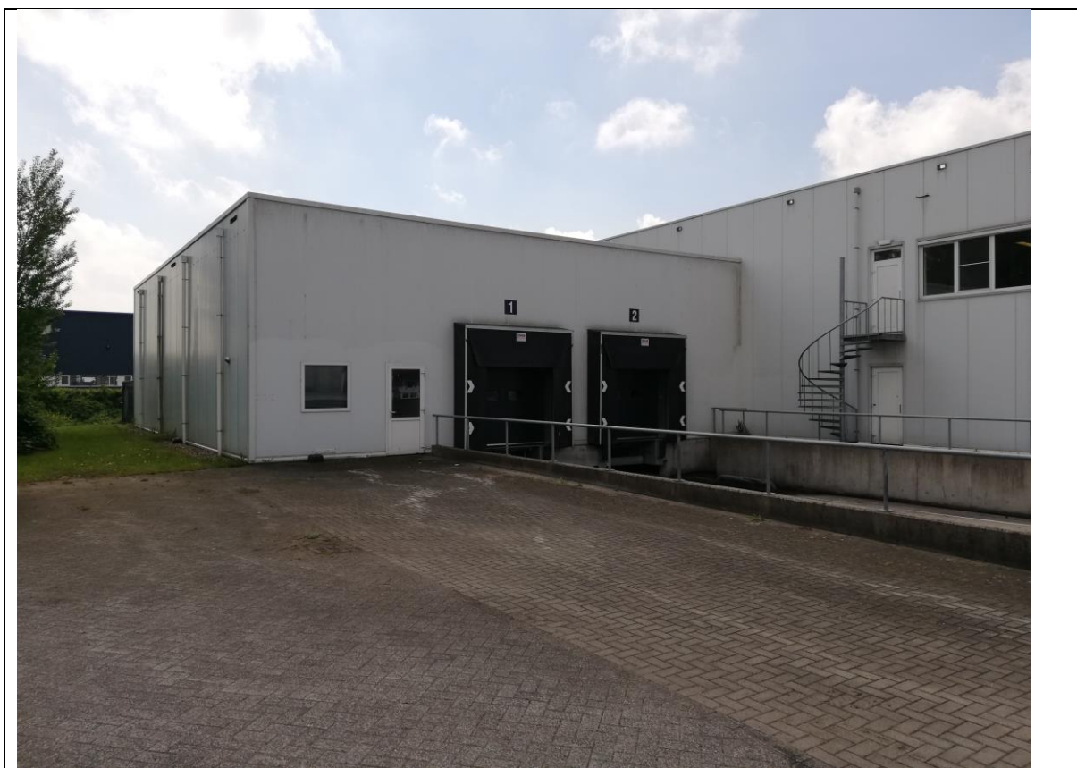
Figuur 1.3 Bedrijfsgebouw vleesverwerker, dat uitgebreid gaat worden, foto vanuit het noorden genomen.
