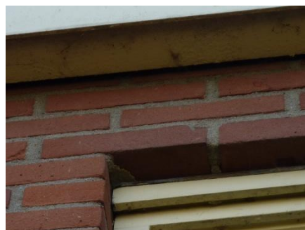
Figuur 7. Ruimte achter betimmering
