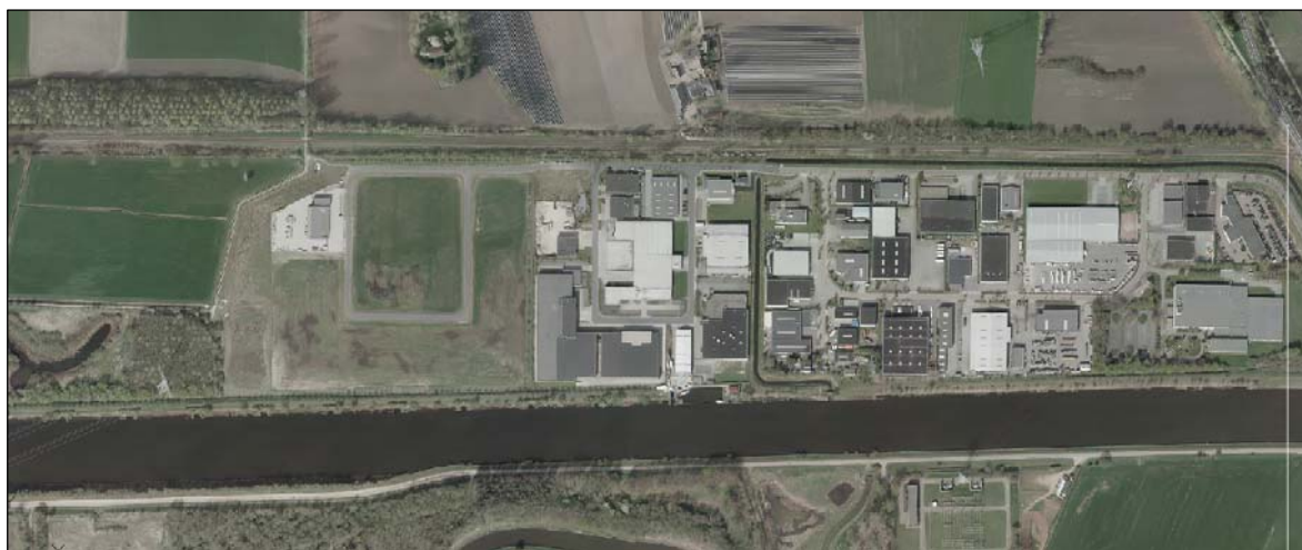
Luchtfoto van de huidige situatie bedrijventerrein Aalsvoort-West
