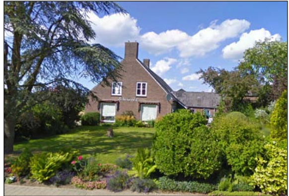
De boerderijwoning -Deventerweg 30 (bron: Google Streetview)
