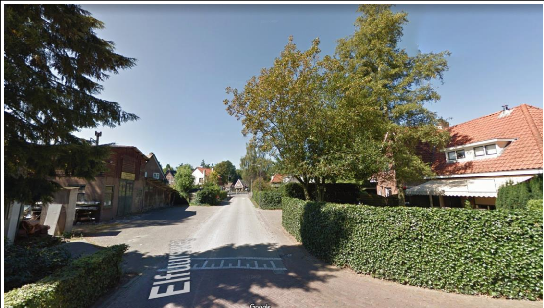
Figuur 9 – Foto van de bestaande (en te slopen) voormalige bedrijfsgebouwen binnen het plangebied aan de zijde van de Elfuursweg, gezien vanuit oostelijke richting - ter hoogte van de Parallelweg (bron: Google Streetview)
