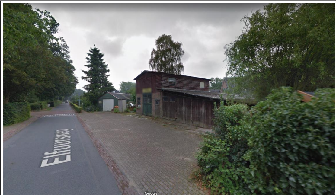
Figuur 8 - Foto van de bestaande (en te slopen) voormalige bedrijfsgebouwen binnen het plangebied aan de zijde van de Elfuursweg, gezien vanuit westelijke richting (bron: Google Streetview)
