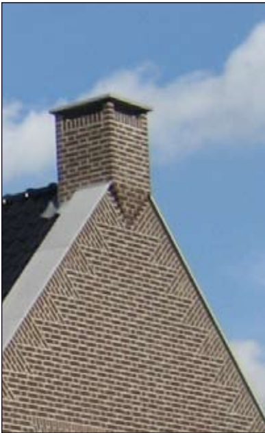
gevel van baksteen, aandacht voor geveldetails (hier: metselwerk)
