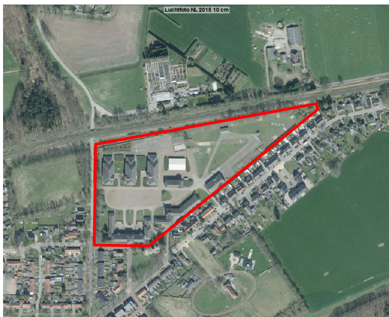
Figuur 1.1: Globale ligging van het plangebied (rood). Spoorlijn bevindt zich direct ten noorden van het plangebied. LuchtfotoNL 2015 © CycloMedia Technology B.V.
