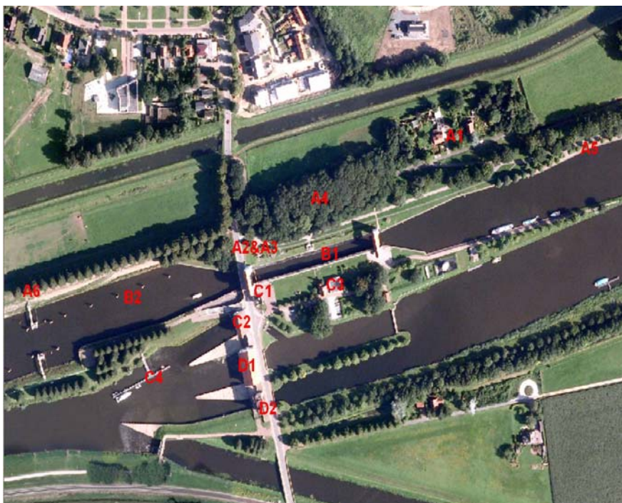
Figuur 2.1 Overzicht van sluiscomplex Eefde
