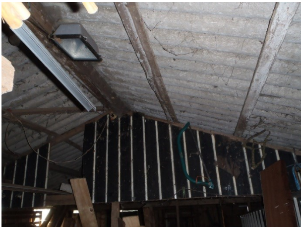
Foto 2: de binnen zijde van schuur 3. Ook hier is het niet beschoten dak van cementgebonden platen zichtbaar.
