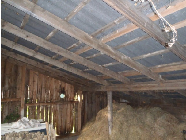
Foto 1: binnenzijde schuur 2. Op de foto zijn de dakplaten zichtbaar en de enkelvoudige houten wand.
