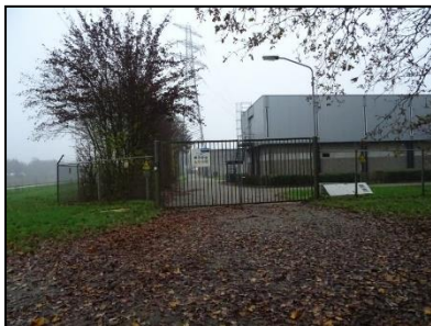
Figuur 3. Ingang van het transformatorstation Lochem.
