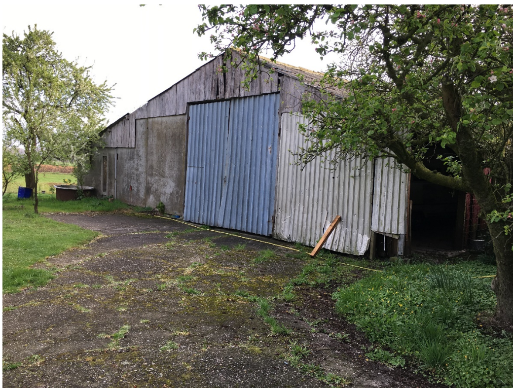
Foto 6, gebouw D, de westzijde
