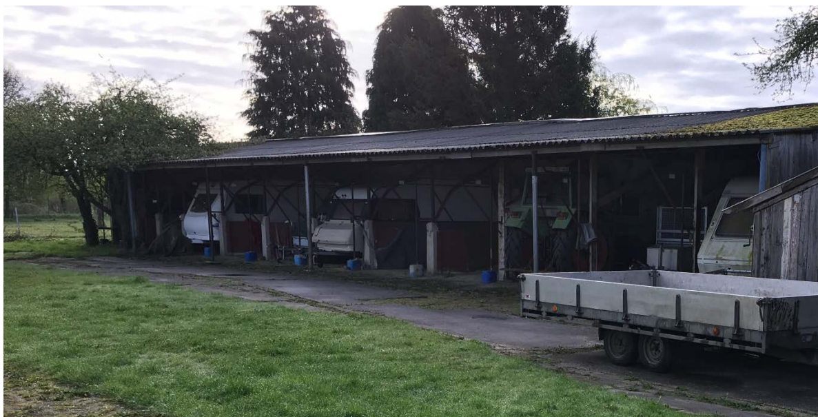
Foto 1, de oude varkensstal, nu caravanstalling
