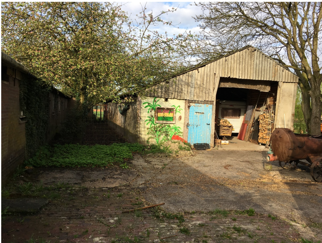
Foto 8, gebouw D, de oostzijde
