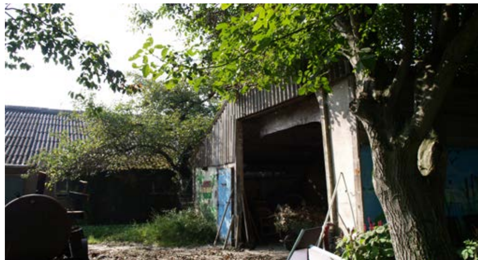
Te slopen gebouwen B en D
