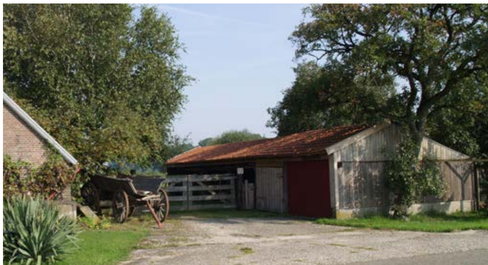
Naast de T-boerderij en het bijgebouw staat dit kleine karakteristiek schuurtje voor houtopslag. De wens bestaat deze te behouden.
