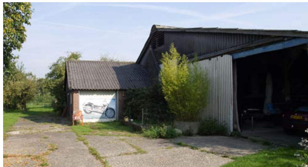
Te slopen gebouw H
