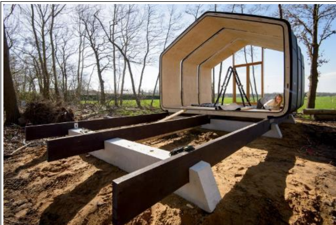
Figuur 7 – plaatsing van een nieuw wikkelhuis (Bron: website Stayokay Hostel Gorssel)
