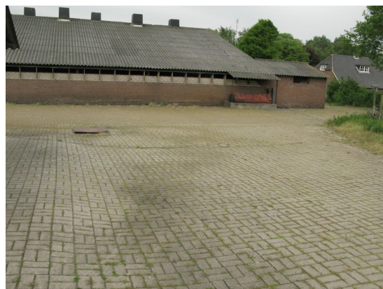
Plangebied is grotendeels verhard met betonklinkers (Horstweg)
